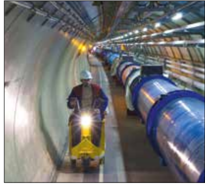
LHC-Tunnel am CERN: Umfang: 27 km Betriebstemperatur: -271,25 °C
